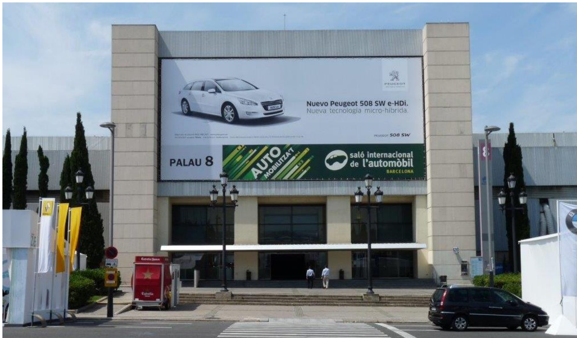
LP8.2 – Lona sobre puerta entrada Pal. 8, central (22,50 x 7,50 m.)
